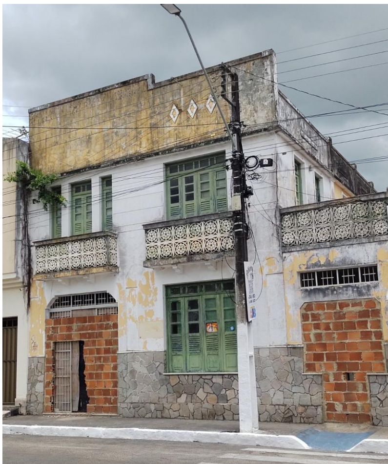
Esta é a situação do prédio desde 2022.
